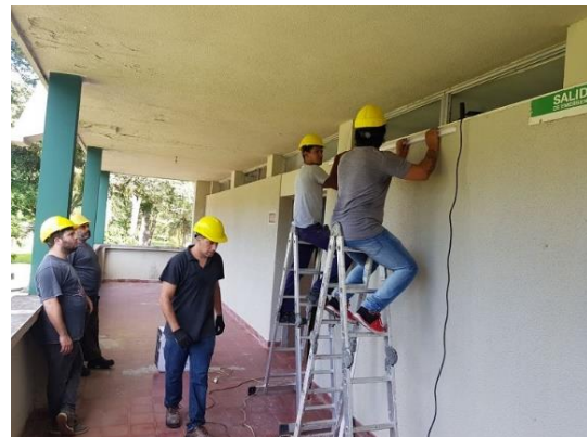
Instalación de red. Programa Educ.ar
